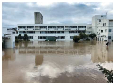
▲浸水したセンター
